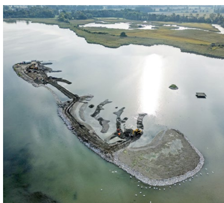
Die Baustelle am 9. September. © AGC
